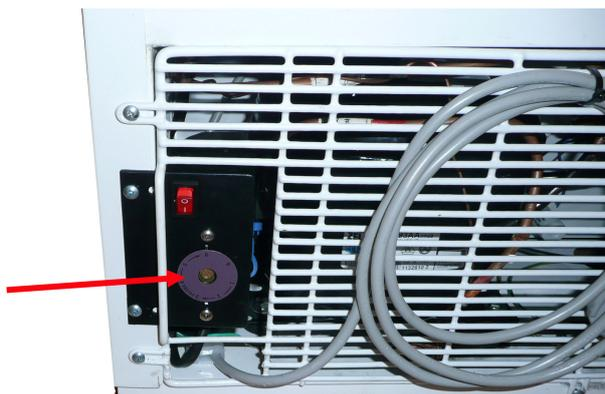
Termostaten kan indstilles fra ca. -12 til -24 °C. En indstilling på pos. 5 vil i de fleste tilfælde være optimal.
